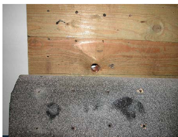
Bild 1.3: Brandprüfung Dachmuster 0,65mm. Aluminium mit Zweischichteinbrennlackierung mit Bitumendachbahn Typ V13 auf 24 mm Holzschalung. 370 A, 255 As. Oben: Versuchsaufnahme mit offenem Verschluss. Mitte: Perforiertes Blech. Unten: Zustand nach der Prüfung.
