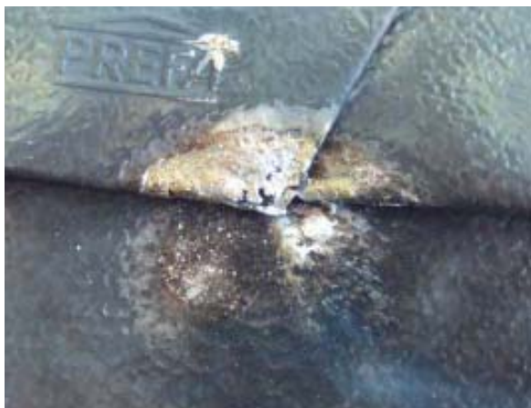
Bild 2.3b: Resultat eines Grenzversuchs mit 200 kA 10/350 an einem Dachmuster mit 200 kA 10/350. Einbrennfläche 12x7mm.
