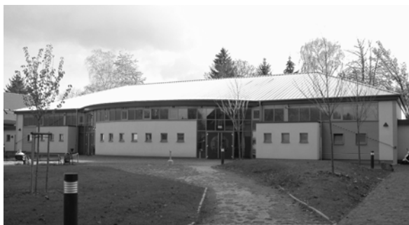
Bild 4.1 a: Metaldach der Mensa der Fachhochschule Südwestfalen. Das Metaldach ist ringsherum an 13 Stellen mit Ableitungen geerdet.
